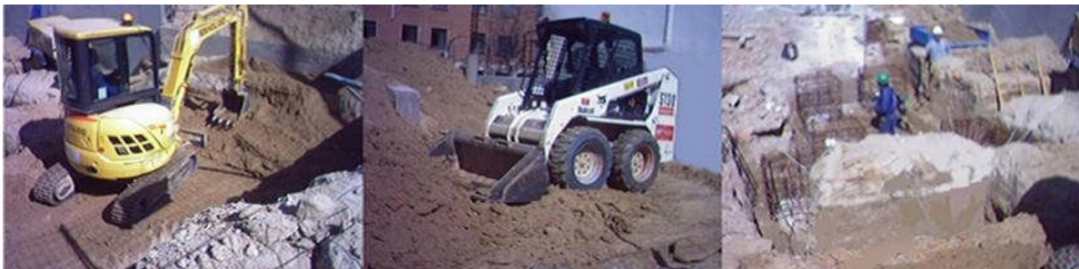
FIGURA 3-7: Pequeñas Maquinas Excavadoras
