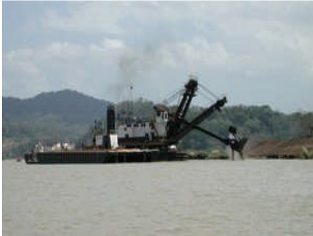
FIGURA 5-5: Dragas con tolva operando en la profundización de el Canal de Panamá
