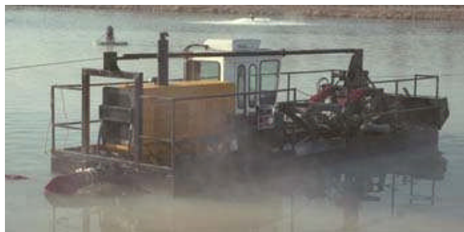
FIGURA 5-7: Dragado y Bombeo en Bajas Profundidades
