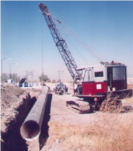
FIGURA 5-4: Construcción de oleoductos
